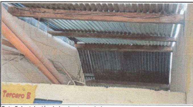
Foto 5: Instalación de lamina troquelada
