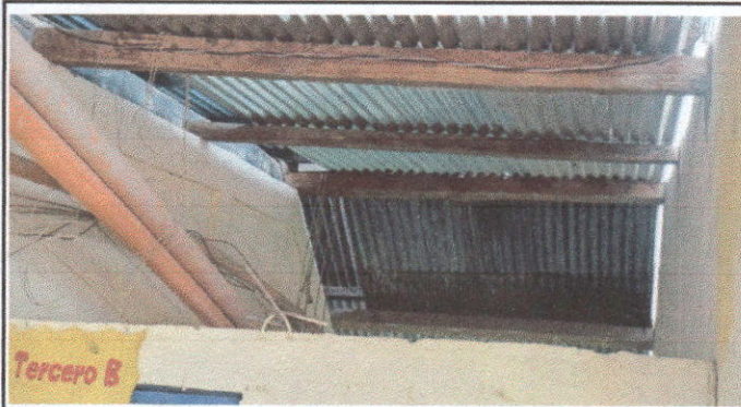
Foto 3: Sustrucción de elementos de fijación
