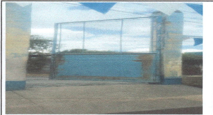
Foto 9: mantenimiento a portones de metal
