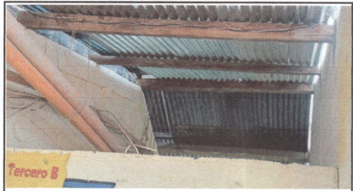
Foto 4: Desinstalación de lamina existente
