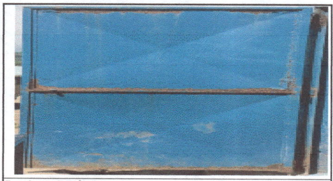
Foto 6: sustitución de puertas en servicios sanitarios
