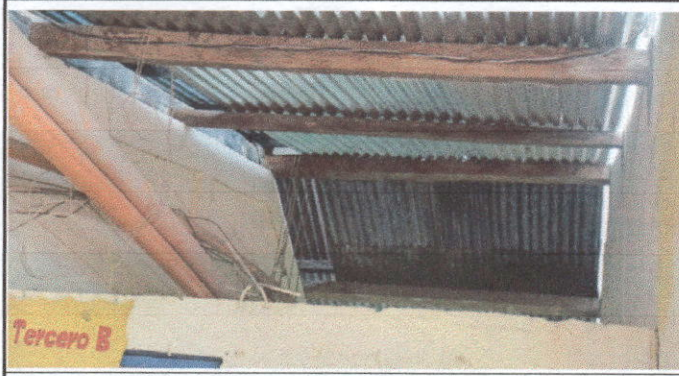
Foto 1: Sustrucción de lámina por lámina troquelada Aluzinc calibre 26
